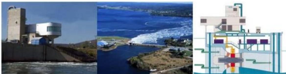
Figura 5 - Visão externa, foto aérea e seção transversal da usina de Annapolis.
